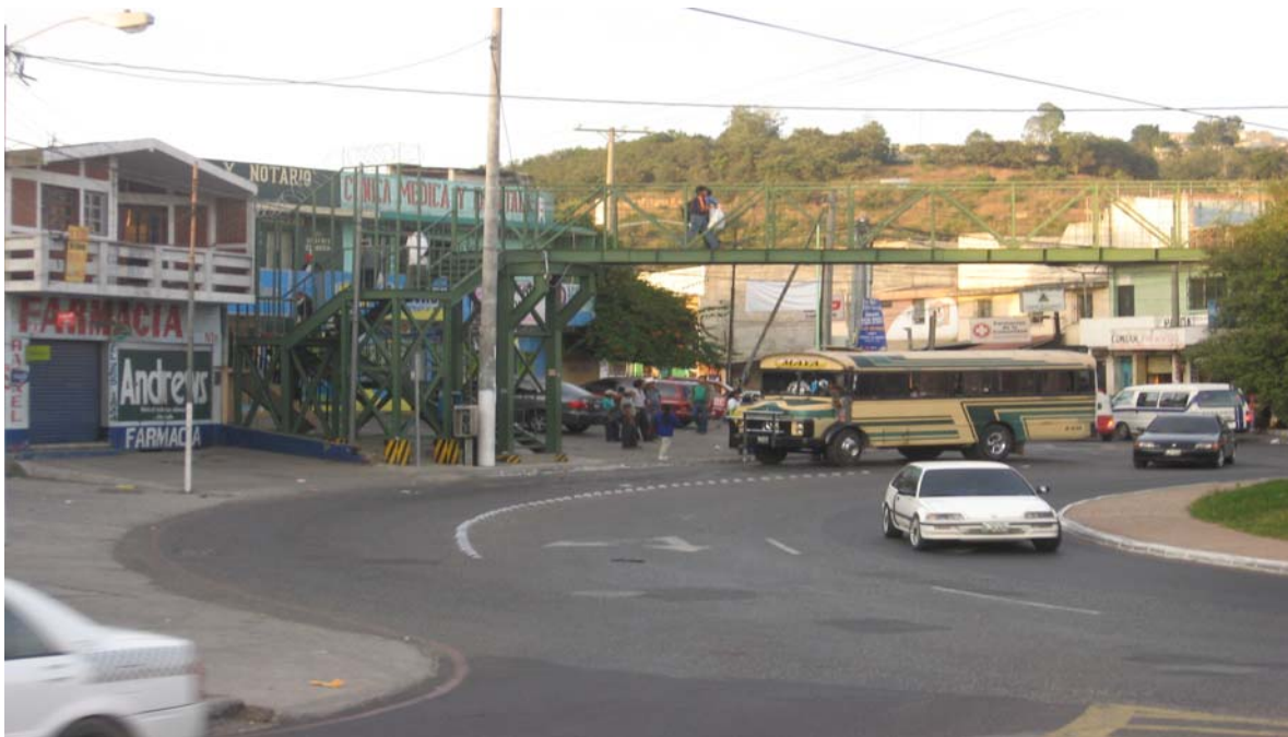
Vista Pasarela Redondel, Colonia Atlántida, Zona 18
