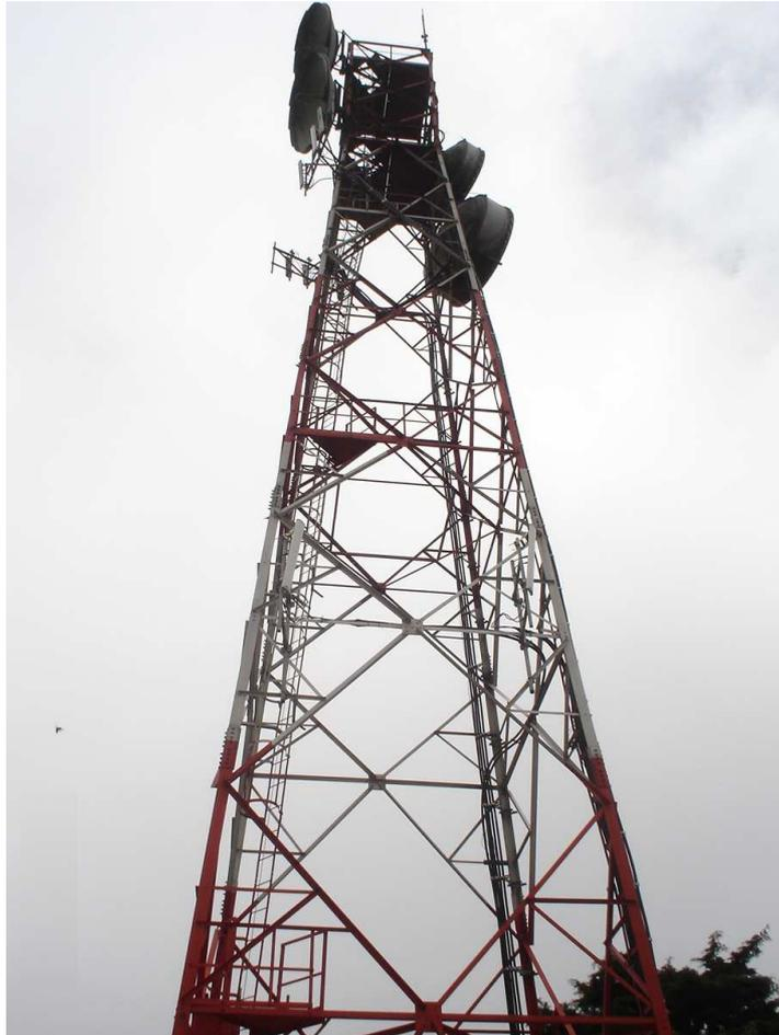
Figura 3: Torre de telecomunicaciones de 60 metros de altura
