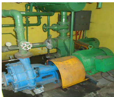
FIGURA 50. Bomba de agua utilizada en la torre de enfriamiento
