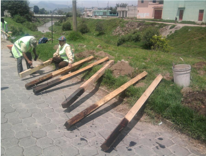
Figura 42: Cercado para protección de arboles en las riberas del río Samalá.
