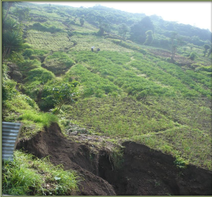
Figura 14. Fotografía amenaza por deslizamiento. Fuente: DMP
