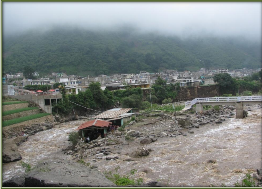
Figura 15. Fotografía Colapso de baños y pilas comunales, cabecera municipal de Zunil. Fuente: .Intervenciones basadas en la planificación y gestión territorial de los riesgos del agua y del medio ambiente con enfoque de multiculturalidad y género en el municipio de Zunil, Quetzaltenango, Guatemala, del diagnostico ambiental.
