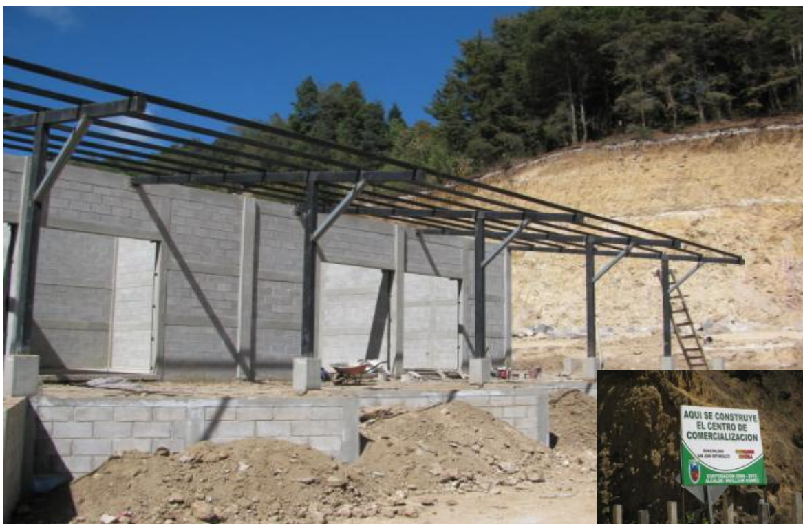
Figura 3. Construcción del centro de acopio de San Juan Ostuncalco.
