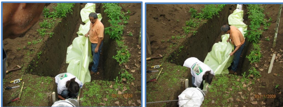
Figura 38: Colocación de la bolsa en la fosa.
