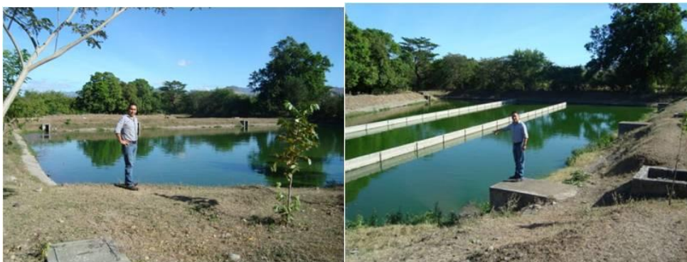
Figura 19: Pilas de oxidación.
