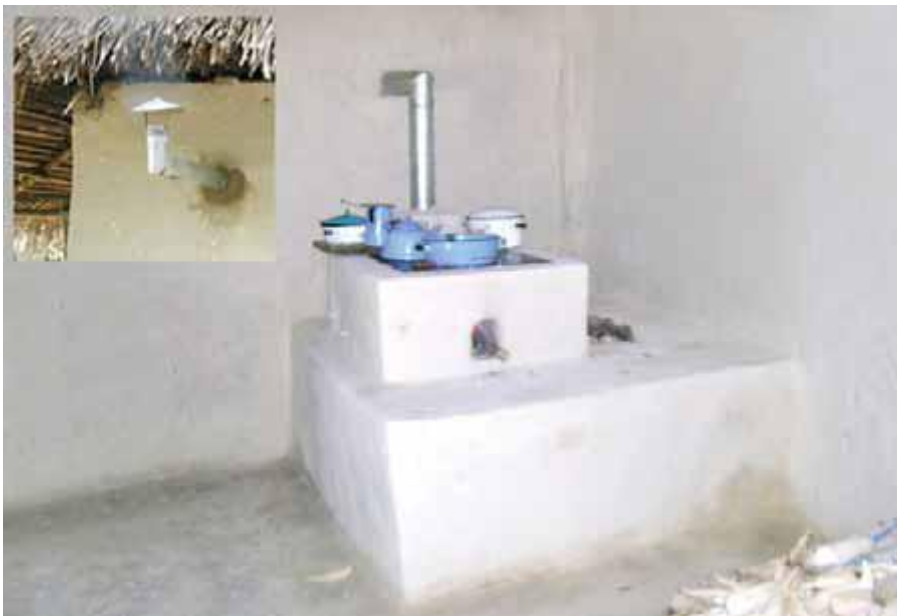
Figura 35. Eco-fogón tipo JUSTA.
