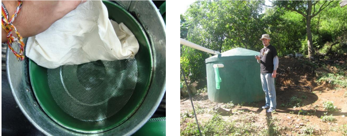
Figura 30. Filtro y cosechadora de agua finalizada.
