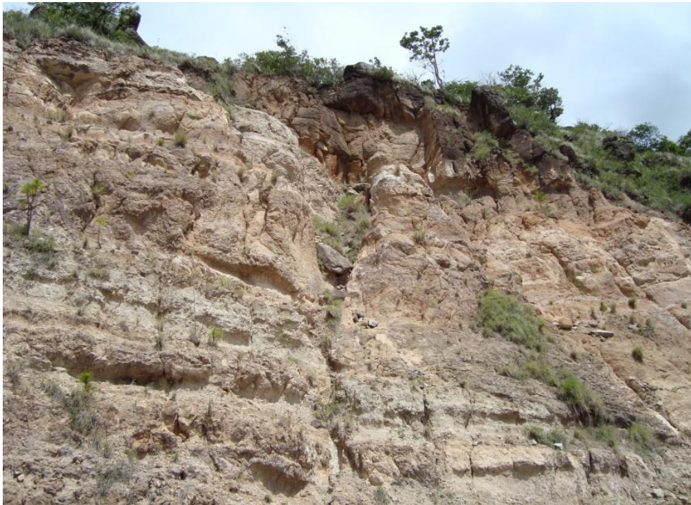
Figura 19. Aludes erosionados al lado de las carreteras.
