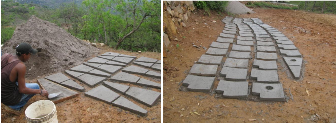
Figura 28. Construcción de placas de cemento.
