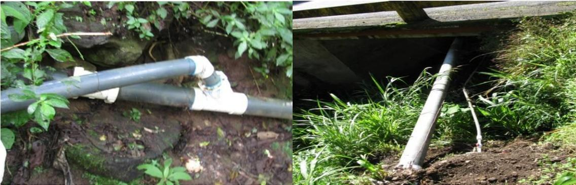
Figura 26: Fotografías de la tubería del acueducto municipal expuesta.
