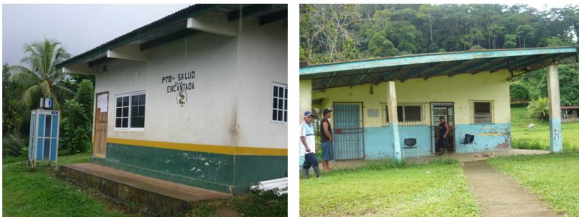
Figura 5. Puesto de salud de La Encantada Cabecera (izquierda) y puesto de salud de Quebrada Bonita (derecha).
