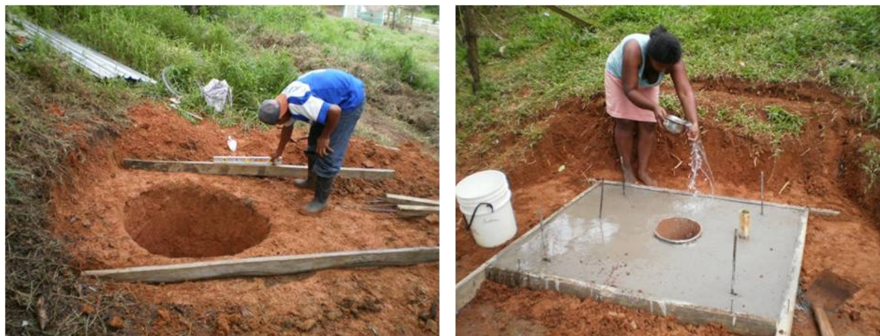
Figura 63. Construcción de la obra. Cada familia beneficiada aportó su mano de obra.
