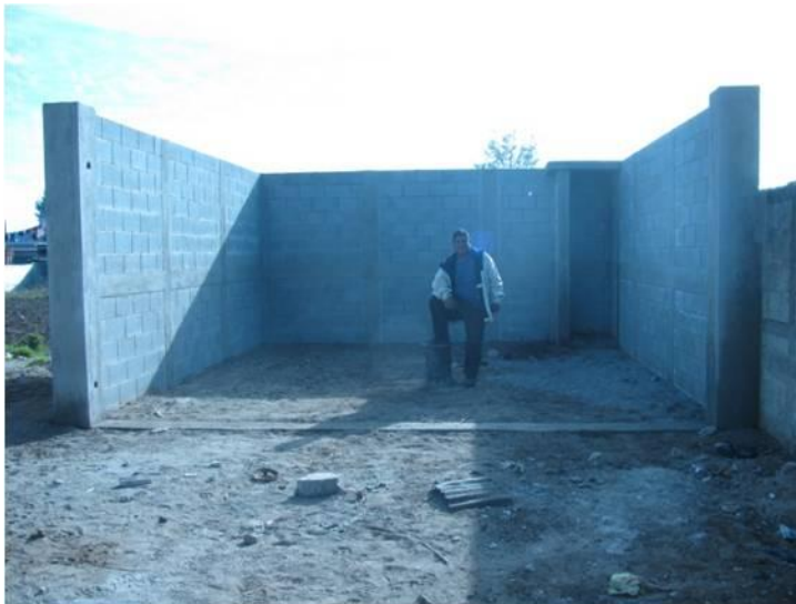
Figura 8 “Estado actual del proyecto de perforación de pozo mecánico, Zona 2.”
