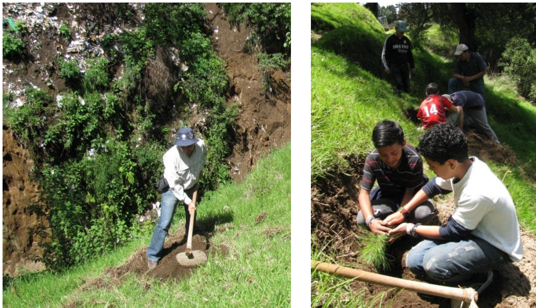
Figura 25 “Construcción de terraza individual y siembra de árboles”.
