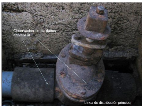
Figura 11. Estado actual de la válvula y línea de infraestructura del mini acueducto por gravedad.
