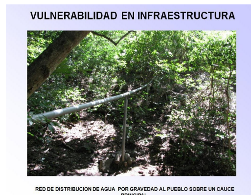
Figura 12. Estado actual de la válvula y línea de infraestructura del mini acueducto por gravedad.
