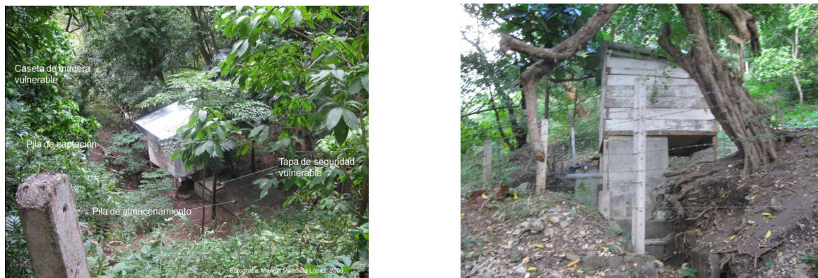
Figura 13. Estado actual de la válvula y línea de infraestructura del mini acueducto por gravedad.
