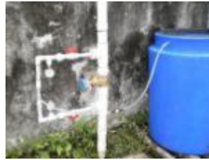
Reparación de filtros en la
