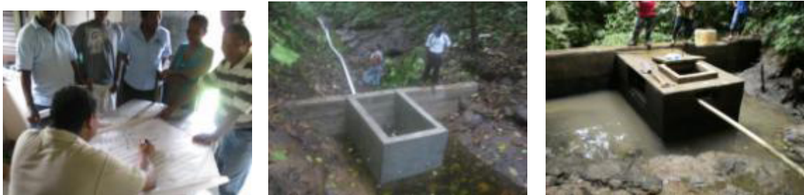
Figura 55 Elaboración de la propuesta con la participación de la JAAR y la restructuración de las toma de agua de la comunidad de Río Indio. Fuente "Intervenciones basadas en la planificación y gestión territorial de los riesgos del agua y del medio ambiente con enfoque de multiculturalidad y género" en el Municipio de Donoso, Panamá.
