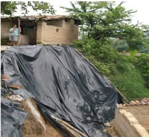
Figura 30. Recorrido por las zonas más afectadas los deslizamientos.
