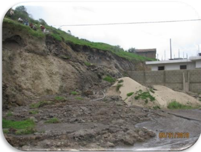
Figura 16. Vivienda ubicada en un punto de riesgo por derrumbe.
