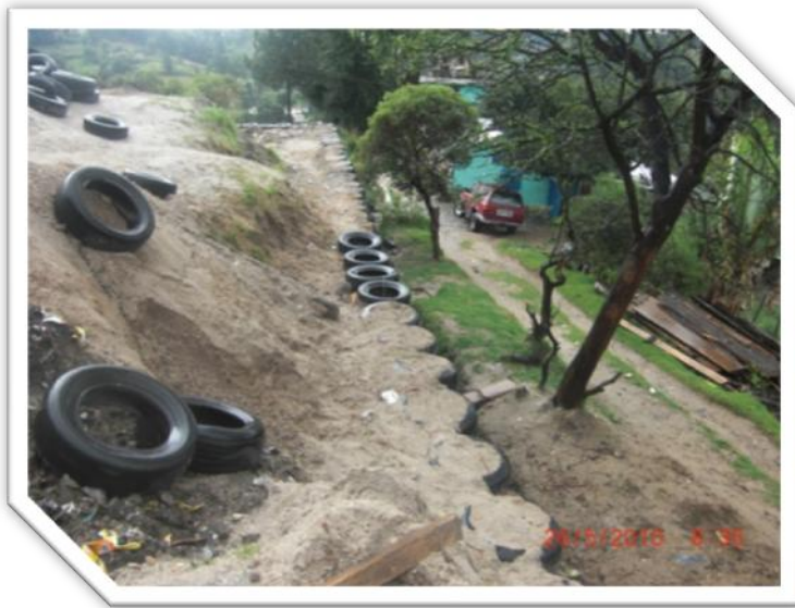
Figura 75. Vista superior de muro de contención con llantas usadas. Escuela Caquixá, aldea El Progreso, San Carlos Sija.
