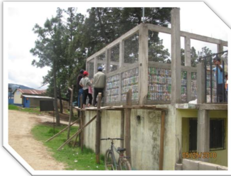
Figura 68. Construcción de aula con eco-ladrillos. Barrio La Cereza, aldea Recuerdo a Barrios, San Carlos Sija.
