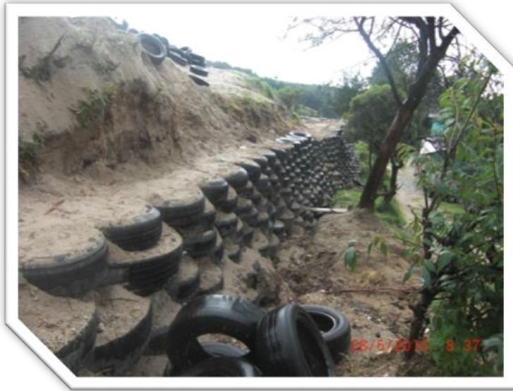
Figura 76. Muro de contención con llantas usadas. Escuela Caquixá, aldea El Progreso, San Carlos Sija.
