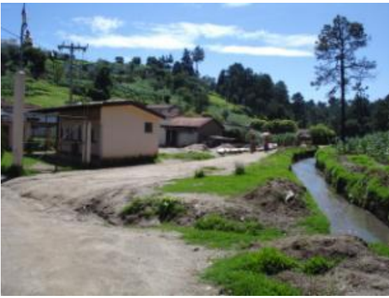
Figura 43: Ubicación del zanjón por donde las aguas negras de SAX conducidas al río Xequijel y su distancia del pozo de agua potable que abastece a la Aldea de SJCh.
