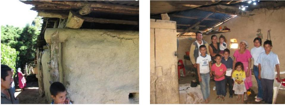
**Figura 27. Vivienda de Isaac Alfonso Linares con Pared a punto de caerse, con vigas externas deterioradas y frágiles.**
