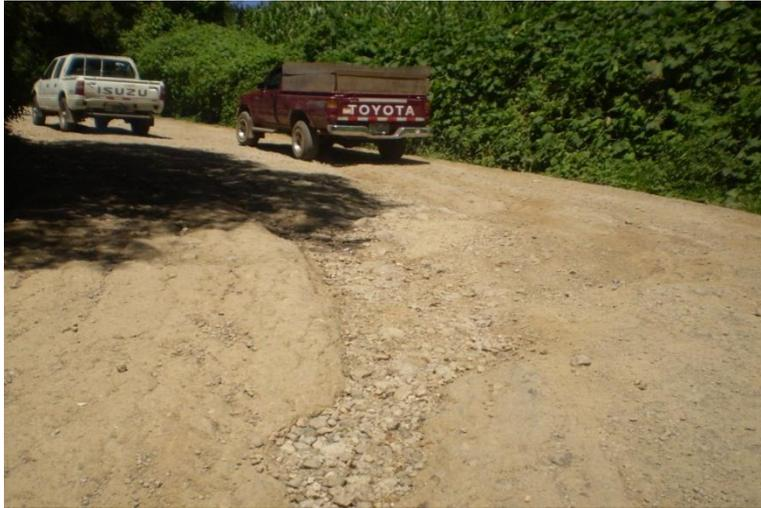
**Figura 21. Calle dañada en Cantón Las Pilas por la ausencia de mantenimiento durante el 2009 por el FOVIAL.**
