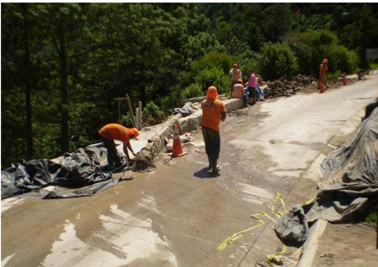
**Figura 14. Labores de reparación de una sección de la calle pavimentada dañada por deslizamientos.**
