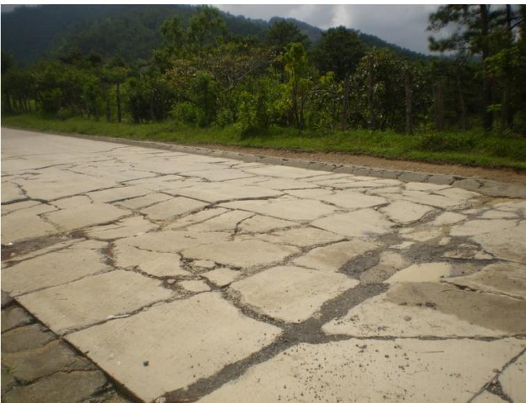
**Figura 16. Fracturación y hundimiento al inicio de la calle que conduce a Las Pilas.**
