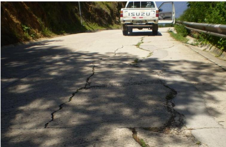
**Figura 15. Fracturación de tramo Río Chiquito de la calle pavimentada que conduce hacia la zona alta.**
