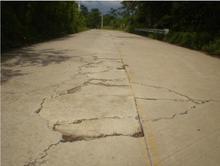
**Figura 18. Hundimiento de la calle pavimentada que lleva al Cantón Teosinte.**
