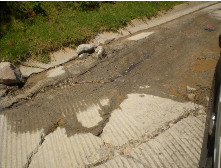
**Figura 20. Sección de calle CHA29 que presenta hundimiento en el pavimento y fracturación.**
