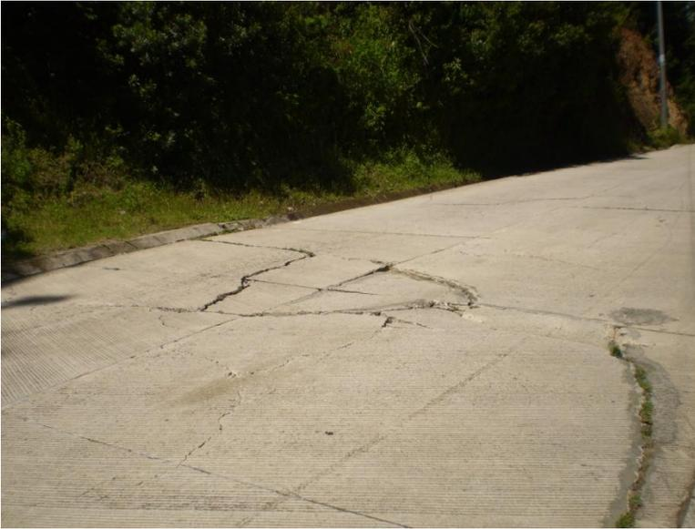
**Figura 19. Sección de la calle CHA29, con daños de fractura.**
