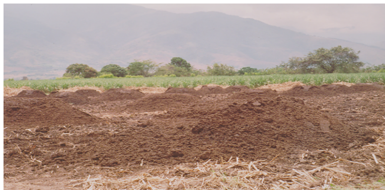
Figura 1. Preparación del terreno
