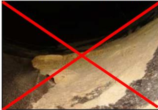
Figura 7. Limpieza deficiente de silos, presencia de hongos.
