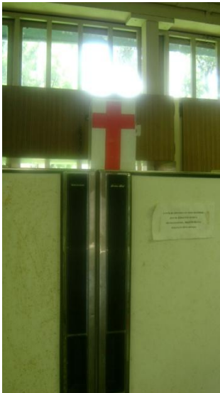
Fotografía No. 11: Ventanas del Lab. (Fuente: Elaboración propia)
