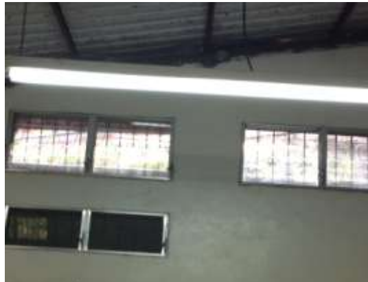
Fig. 4 Estructura interna en las instalaciones del Laboratorio Experimental
