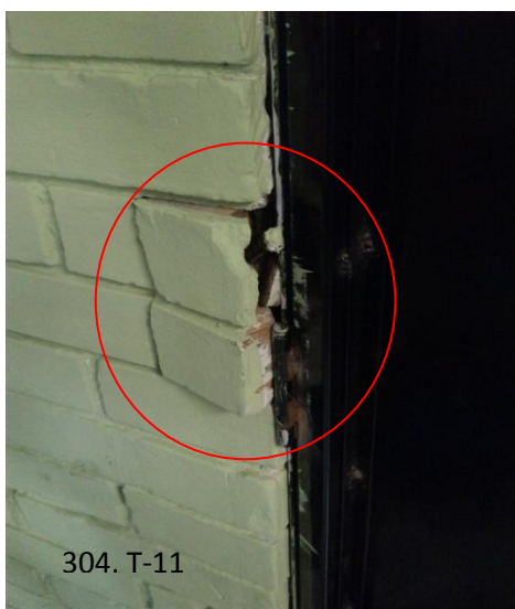
Imagen 5: Muros de cercamiento
