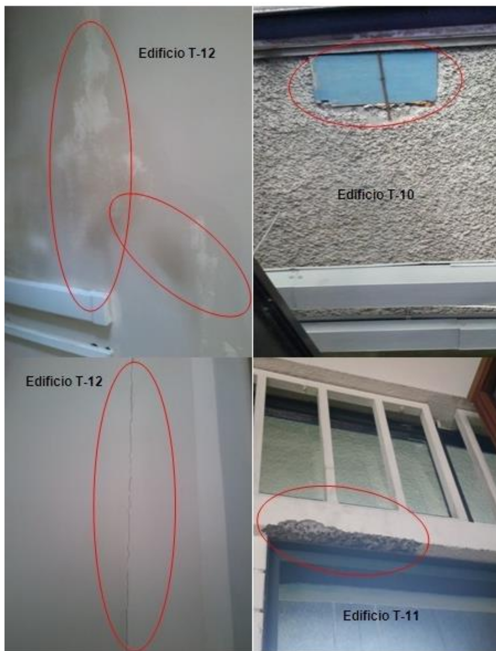
Imagen 4: Muros y Techos de las oficinas.
