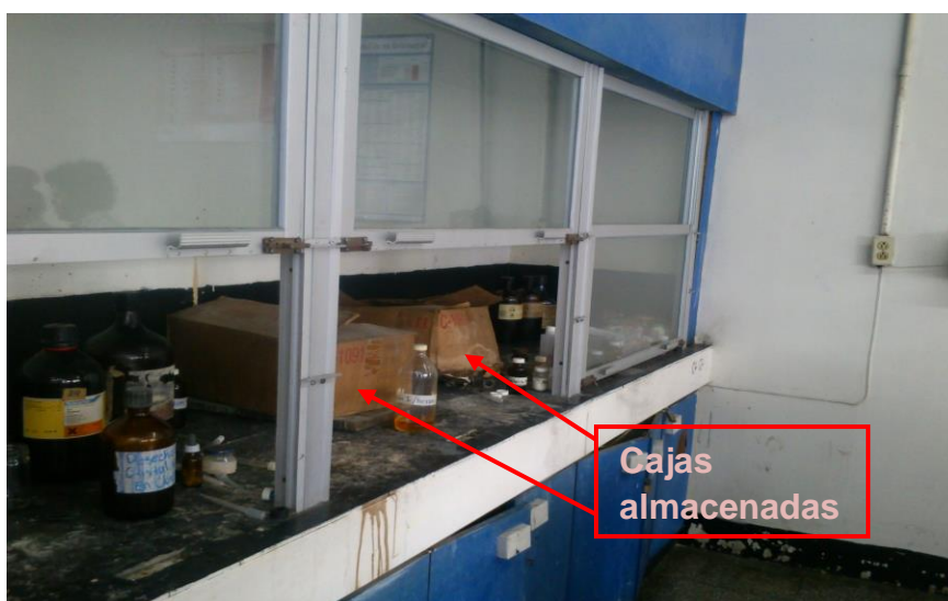
Imagen 2: Campana de extracción de gases usada como almacenaje
