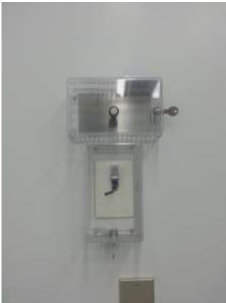
Fotografía 14. Sensores de temperatura y humedad de la cámara de Estabilidad con Temperatura y Humedad controlada.
