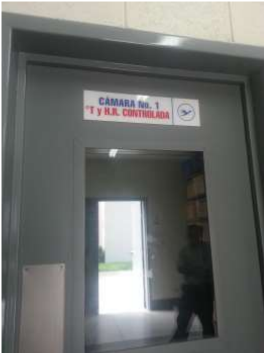
Fotografía 13. Cámara de Estabilidad con Temperatura y Humedad controlada. Ubicada en Laboratorios Donovan Werke.
