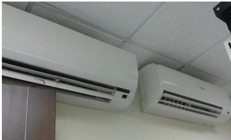
Figura 18. Aletas de equipo de aire acondicionado tipo mini split
