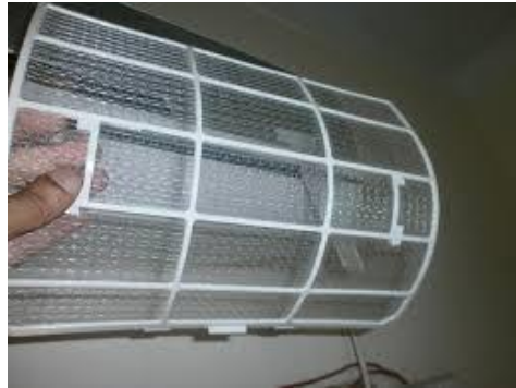
Figura 15. Filtro de aire de un equipo tipo mini split
