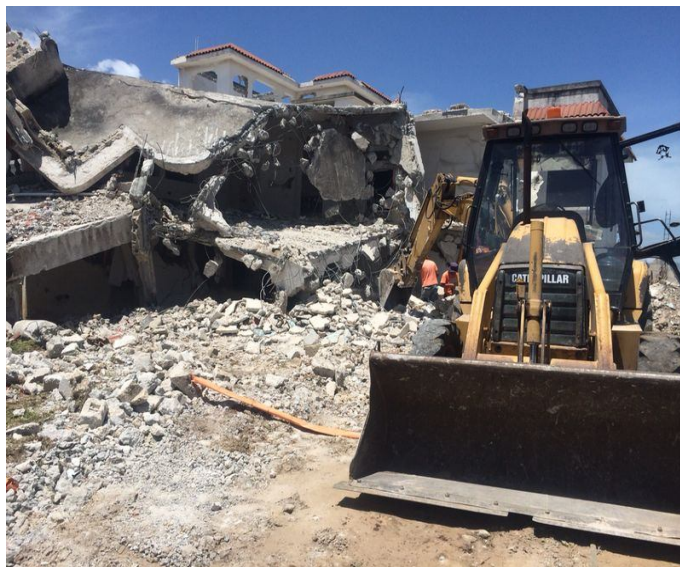
Figura. 6. Daños en vivienda por fallas en método constructivo
