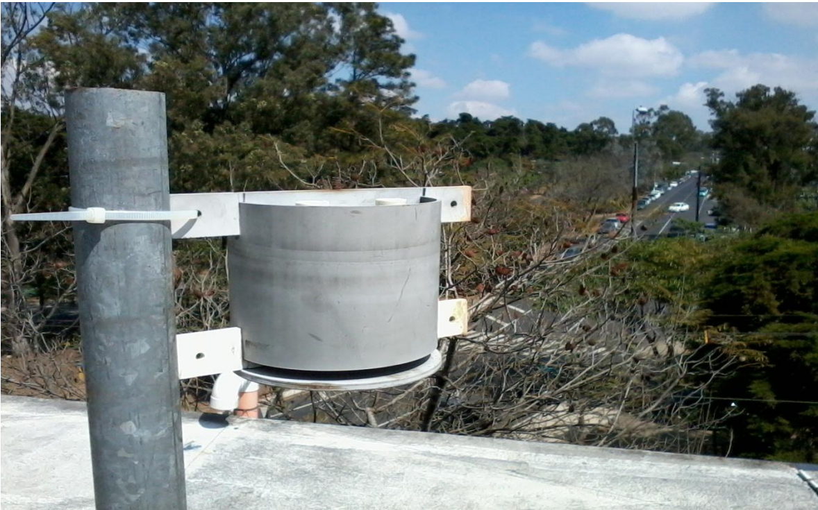
Figura No. 7 Contenedor para tubos pasivos de NO 2 .
