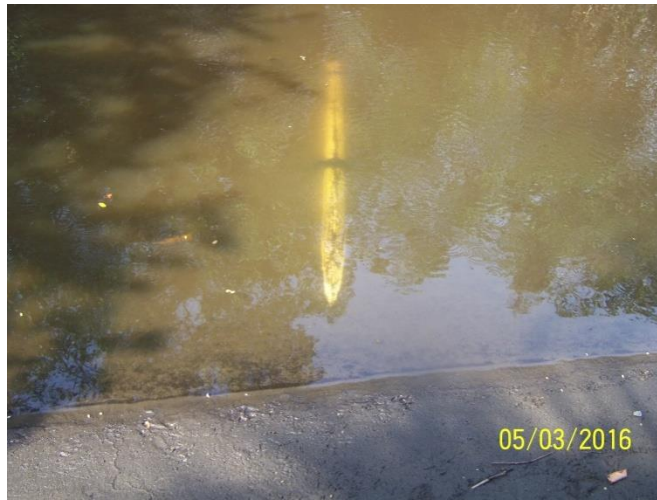
Fotografía 9. Tubería del Pozo comunal de Aldea La Curvina a Aldea Agua Dulce
