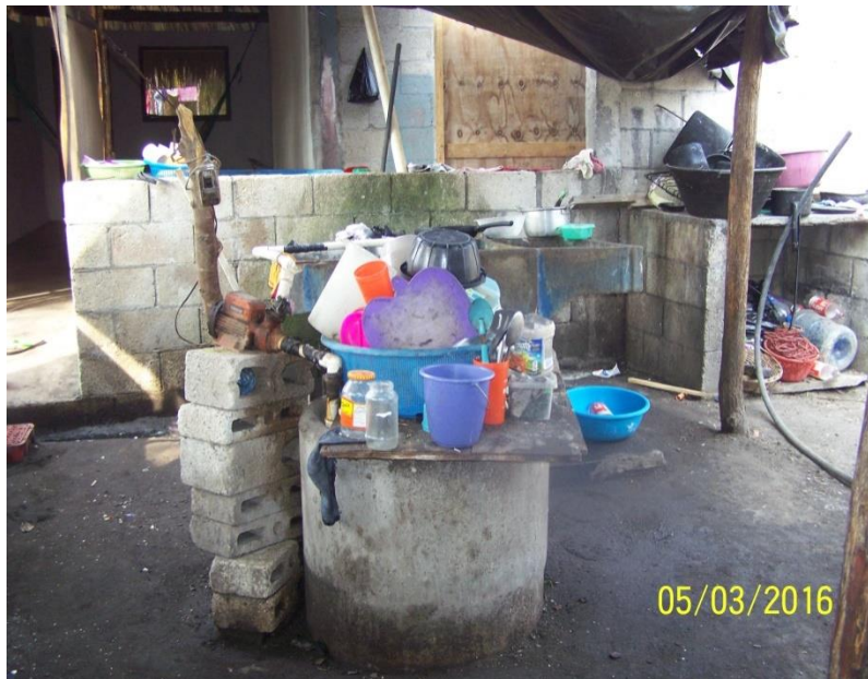
Fotografía 4. Evidencia de poco mantenimiento a los pozos
