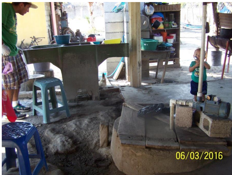
Fotografía 14. Pozo dentro de vivienda.
