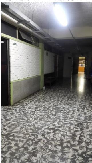
Edificio T-11 Tercer Nivel
