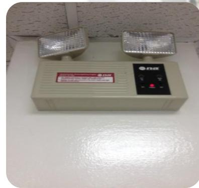
*Imagen 22: El laboratorio de microbiología cuenta con una luz automática que entra en función media vez se quede sin energía el lugar, constantemente se hacen revisiones de la batería y se hacen pruebas de funcionamiento.*
