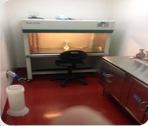
*Imagen 8: Imagen del área de siembra de muestras de microbiología esta construida sus divisiones con tabla yeso liso, todas las intersecciones poseen curva sanitaria para facilitar la limpieza, al igual el piso esta recubierto con pintura epoxica que facilita la limpieza de los mismos, todas las paredes están repelladas y pintadas y se cuenta con un programa de mantenimiento y limpieza diaria.*
