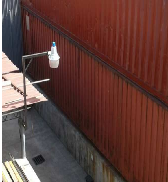
Luces instaladas en el área de parqueo
