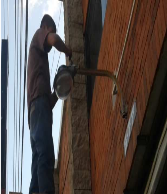
Trabajos de conexión de luces externas
