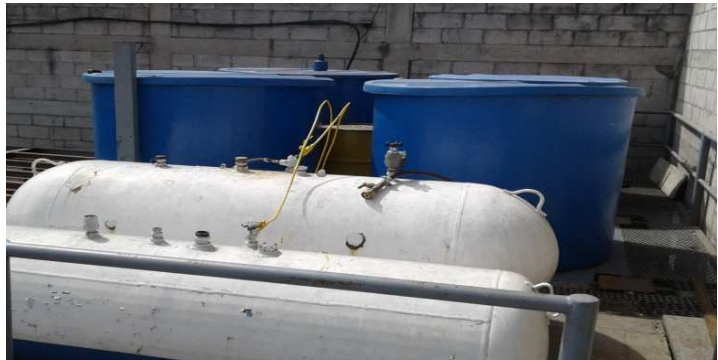
Delimitación del área de los tanques de almacenamiento por medio de una construcción de block solida
