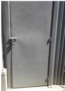
Instalación de puerta en el área de los tanques de almacenamiento
