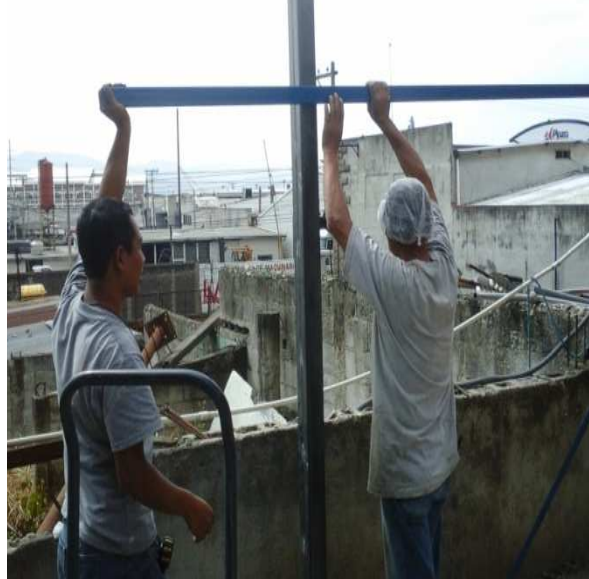
Trabajos de construcción de una barrera física
