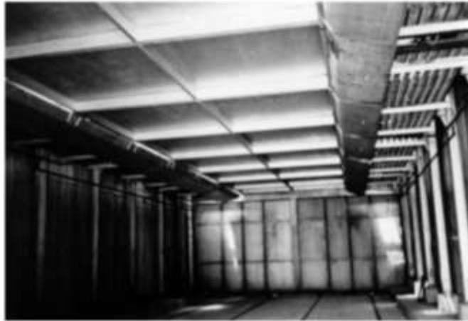
Figura 16. Cámara de secado con plafón central y desviadores colgantes laterales
