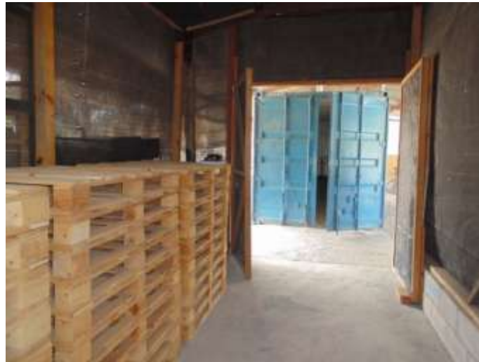
Figura 29. Bodega para embalaje tratado colindante al horno de tratamiento térmico
