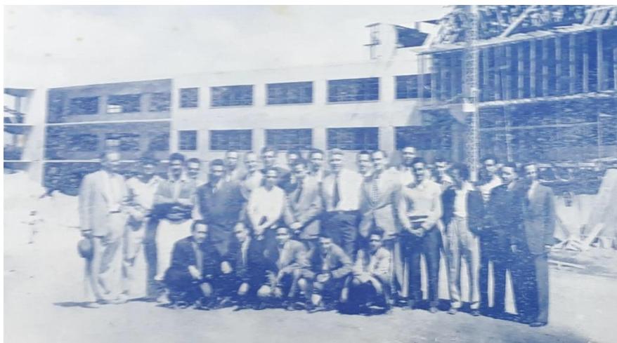
Personal que corresponde exclusivamente a la construcción del Hospital. (Álbum Gráfico, 1946)
