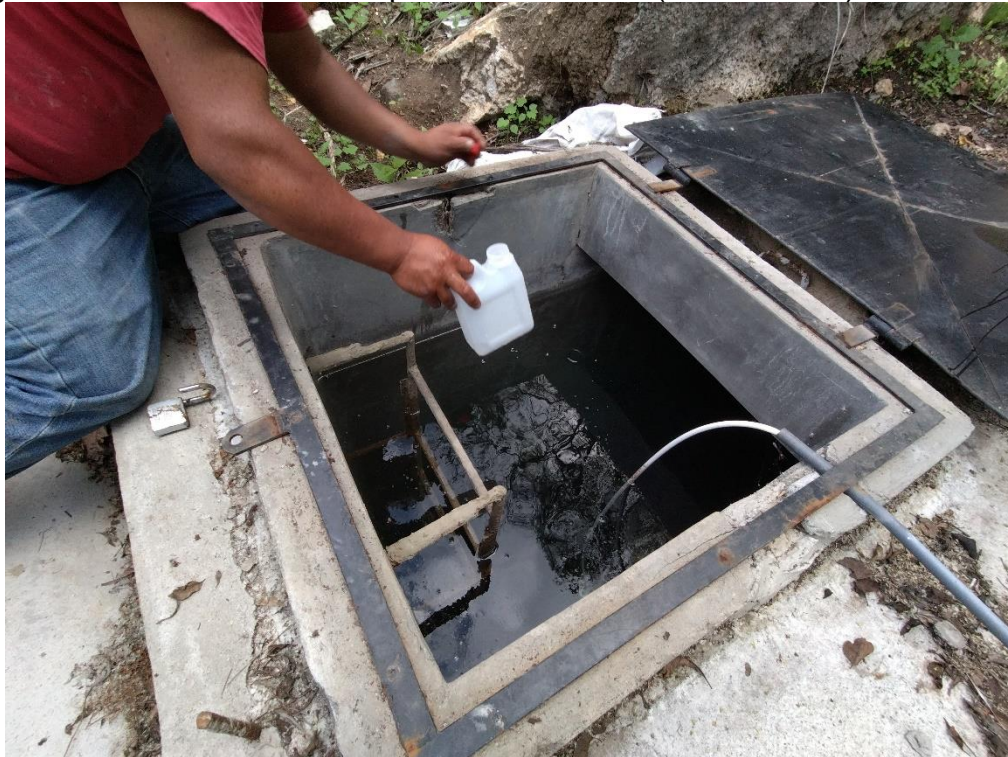
Imagen No. 7 Muestreo de Tanque de distribución (Circuito Azul)
