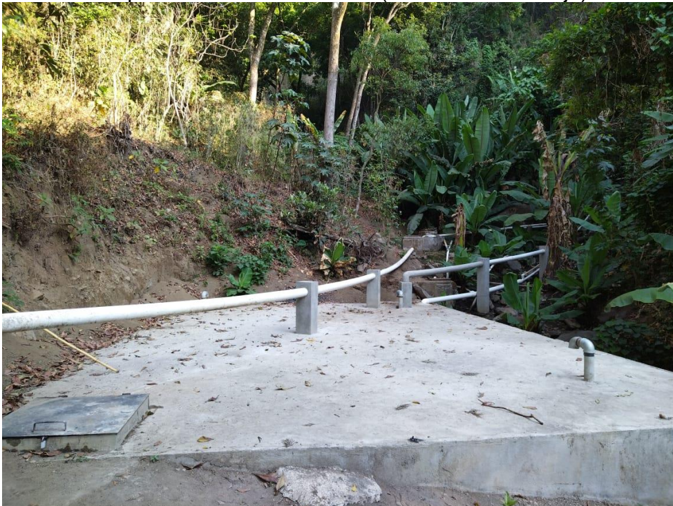
Imagen No. 2 Tanque de distribución Pacua (Circuito Verde-Rojo)
