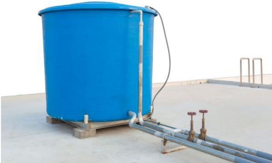
Figura 16. Tanque de almacenamiento de agua
