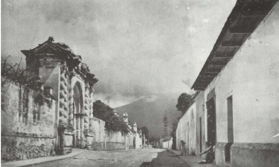
Calle de la Ciudad de Antigua Guatemala, conocida como "Calle de los Pasos", por las capillas que hay en todo su trayecto y que muestran uno a uno los pasos del vía crucis; fueron construidas en el siglo XVII. Inicia en la esquina de la 7ª. Calle y culmina en la Ermita del Calvario. (Foto: El Indio. Guatemala)
