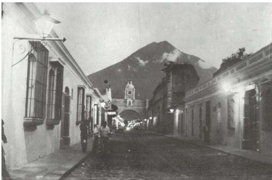
Calle del Arco de Santa Catalina, durante la noche con el nuevo sistema de alumbrado subterráneo introducido en años recientes, con el que no se observan cables aéreos ni postes. (Una de las medidas para la conservación de la ciudad), Al fondo el Volcán de Agua. (Foto: El Ángel)
