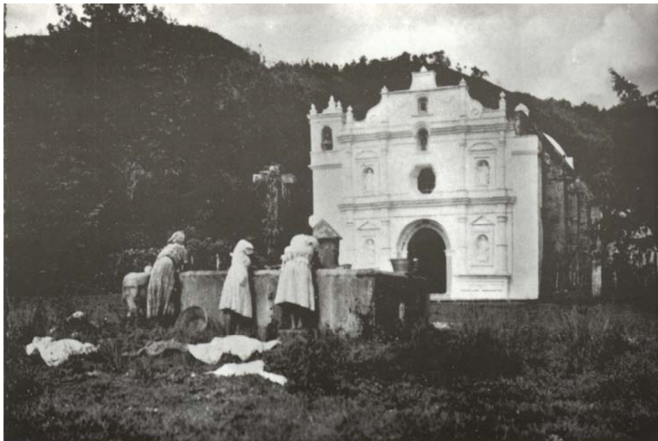
Iglesia de San Cristóbal el Bajo, construida en el siglo XVII. Ha sufrido serios daños en diferentes épocas, particularmente en el terremoto del 4 de febrero de 1976. En la actualidad es objeto de reconstrucción.
