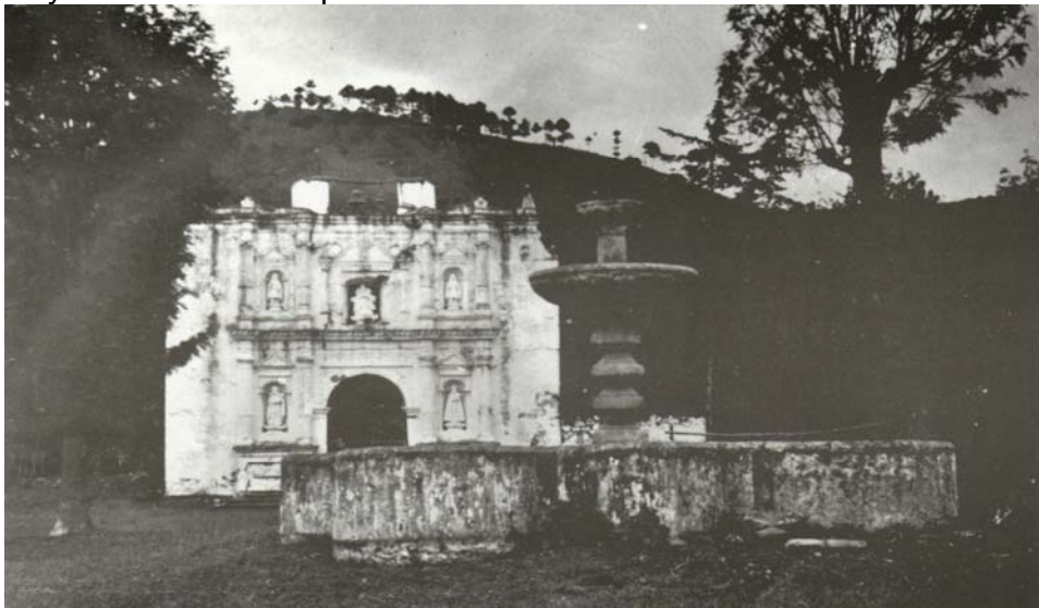
Fuente e Iglesia de San Gaspar. Construidas en el siglo XVII. La Iglesia quedó fuera del servicio religioso en la década de 1930.
