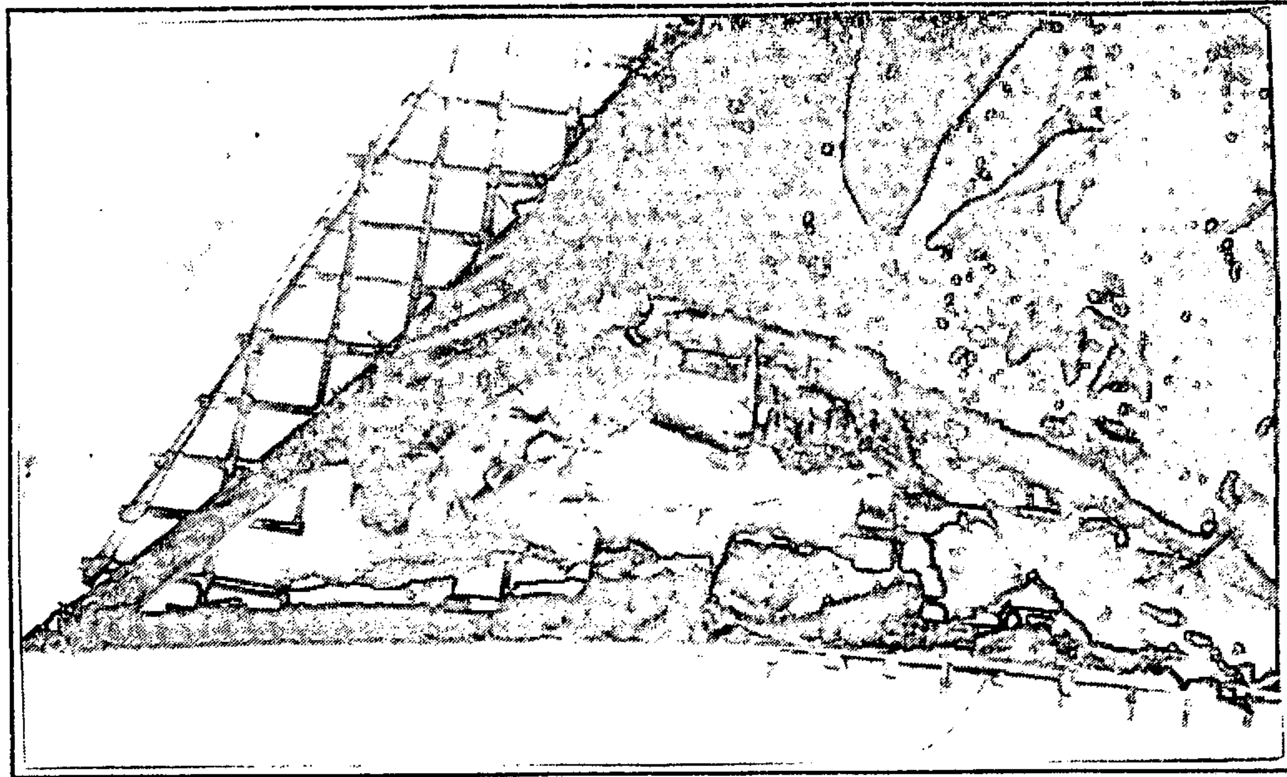
- Detalle de los deterioros de la pechina de San Juan.
