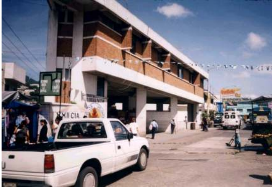
Estación de Bomberos Voluntarios a la vecindad del parque municipal.
