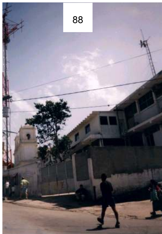
Instalaciones de Telgua en la Cabecera Municipal
