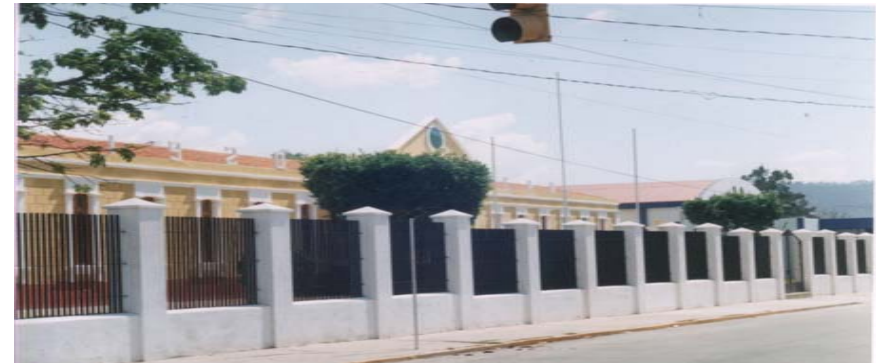
Instalaciones remodeladas del Instituto Centro Americano para Varones. 2003
