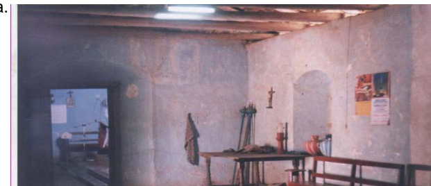
Antigua escuela de San Pedro Pinula, construida a la par de la Iglesia
