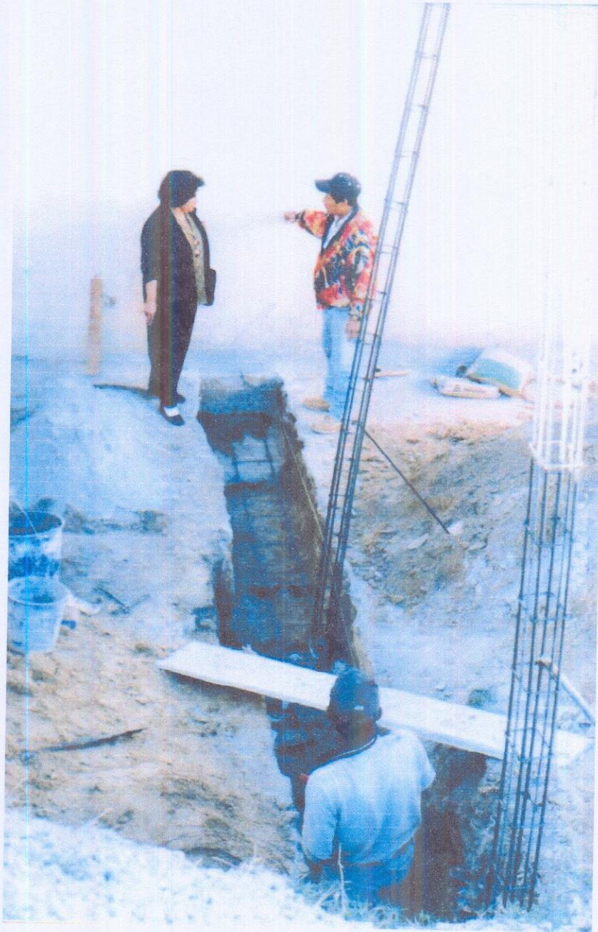
**Fundición de vigas que servirán para levantar el muro que servirá de base a guardianía del edificio de Facultad de Humanidades Sección Jalapa.**
