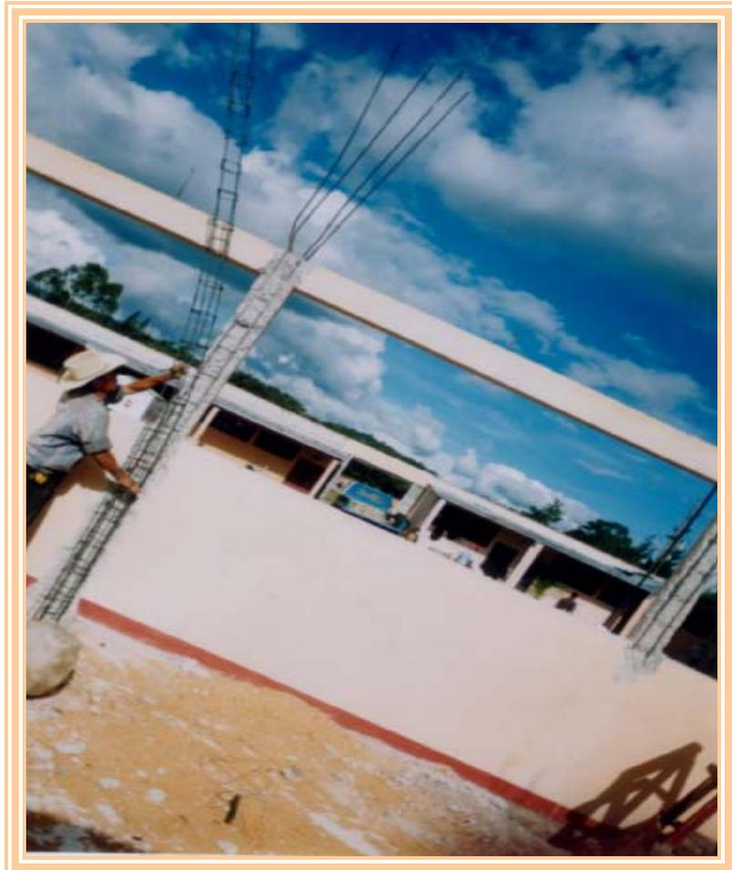
**Reforzando columnas (7 columnas) para el sostenimiento de la loza en la sala de informática.**
