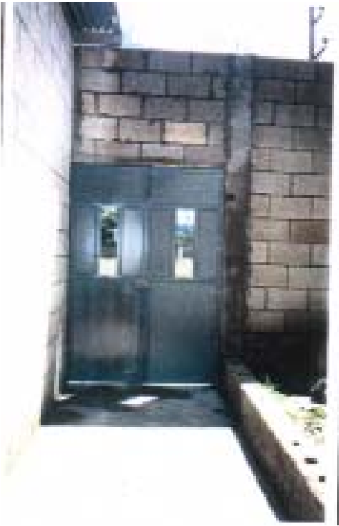
Instalación de la puerta principal del edificio de la Facultad de Humanidades, Sección Jalapa. (Fuente Facultad de Humanidades, Sección Jalapa. Universidad de San Carlos de Guatemala).
