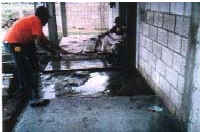
Fundición de piso de cemento en las instalaciones de la Facultad de Humanidades, sección Jalapa. (Fuente Facultad de Humanidades, Sección Jalapa. Universidad de San Carlos de Guatemala).
