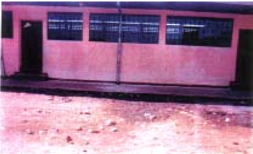
Reconstrucción terminada del Salón de Clases No. 6 en las instalaciones de la Facultad de Humanidades, Sección Jalapa. (Fuente Facultad de Humanidades, Sección Jalapa. Universidad de San Carlos de Guatemala).
