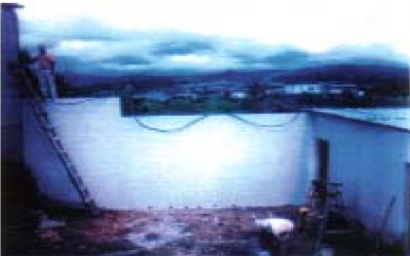
Repello de paredes del salón de clases No.6 en las instalaciones de la Facultad de Humanidades, Sección Jalapa. (Fuente Facultad de Humanidades, Sección Jalapa. Universidad de San Carlos de Guatemala).
