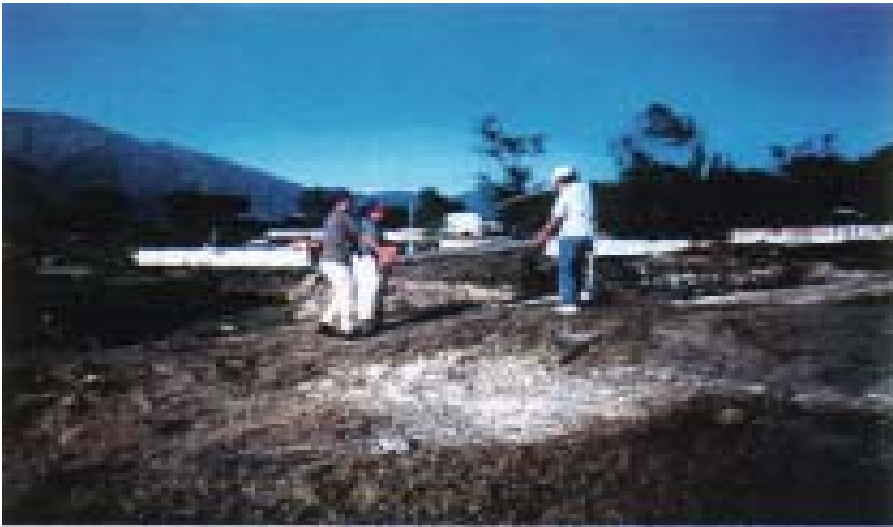
Reconocimiento y limpieza del terreno en las instalaciones de la Facultad de Humanidades, Sección Jalapa. (Fuente Facultad de Humanidades, Sección Jalapa. Universidad de San Carlos de Guatemala).
