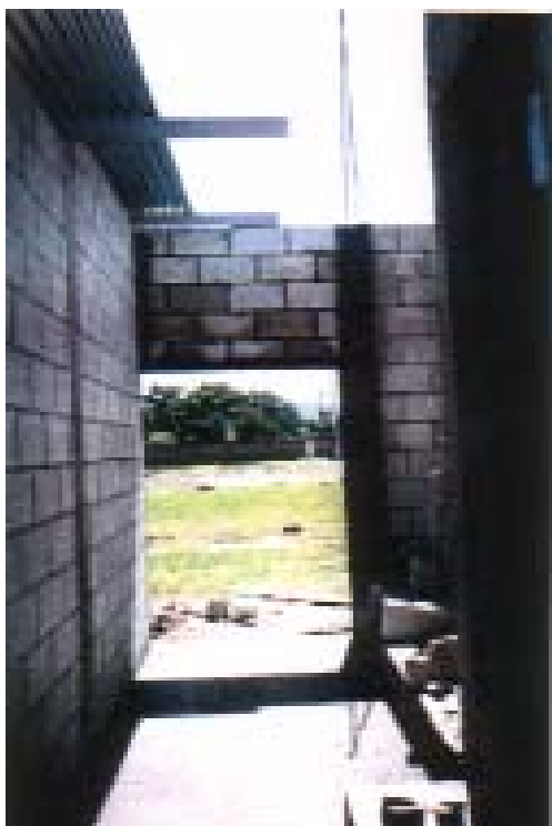
Construcción de pared y fundición de columnas de la entrada principal en las instalaciones de la Facultad de Humanidades, Sección Jalapa. (Fuente Facultad de Humanidades, Sección Jalapa. Universidad de San Carlos de Guatemala).
