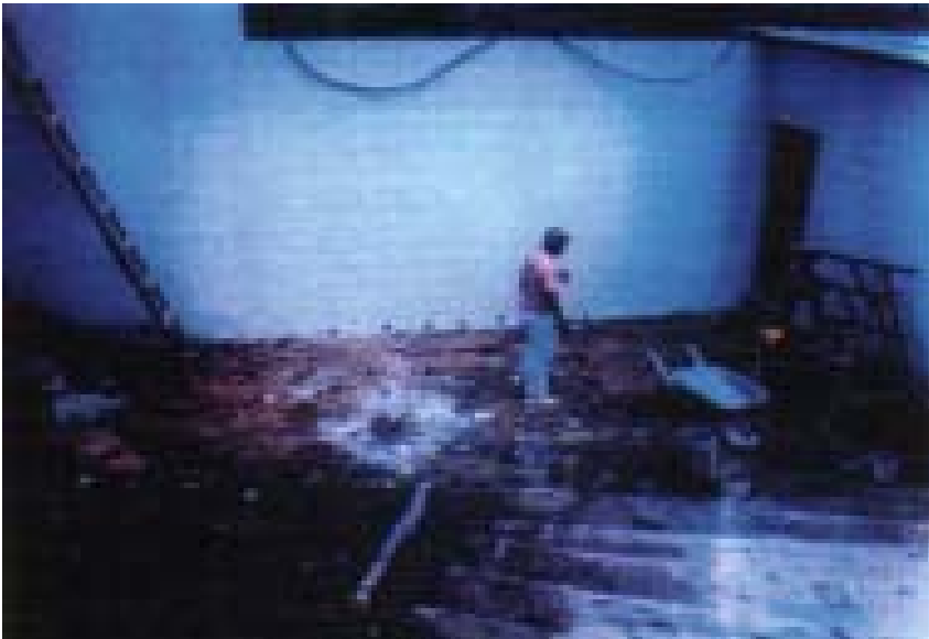
Inicio de la reconstrucción del salón de clases No. 6 en las instalaciones de la Facultad de Humanidades, Sección Jalapa. (Fuente Facultad de Humanidades, Sección Jalapa. Universidad de San Carlos de Guatemala).
