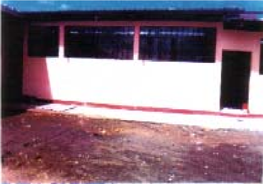
Instalaciones de balcones en el salón de clases No. 6 en las instalaciones de la Facultad de Humanidades, Sección Jalapa. (Fuente Facultad de Humanidades, Sección Jalapa. Universidad de San Carlos de Guatemala).
