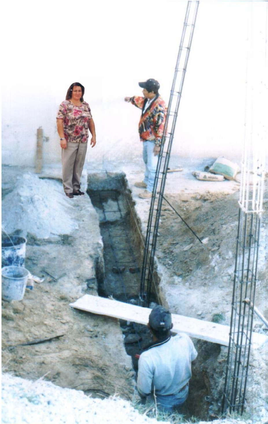
Fundición de vigas de humedad que se utilizaran el levantado de paredes de la bodega del edificio de la Facultad de Humanidades Sección Jalapa.
