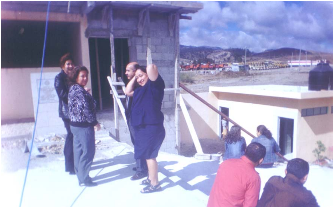
Colocación de parales para fundir losa de Bodega del edificio de la Facultad de Humanidades Sección Jalapa.
