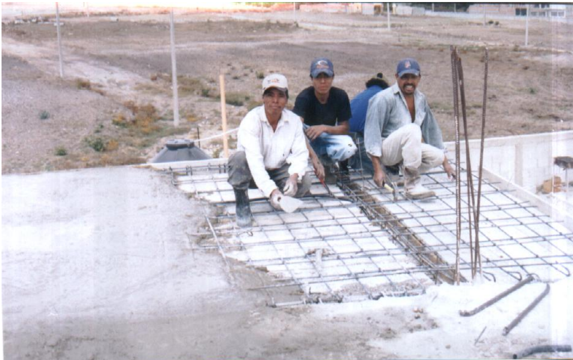
Fundición de terraza de la bodega del edificio de la Facultad de Humanidades Sección Jalapa.
