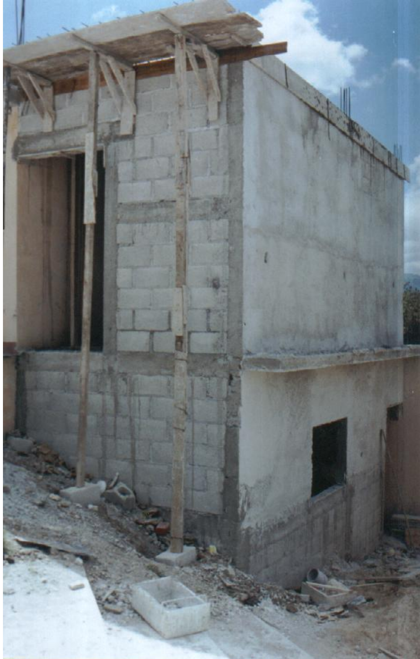
Repello de paredes de bodega y guardianía del edificio de la Facultad de Humanidades Sección Jalapa.
