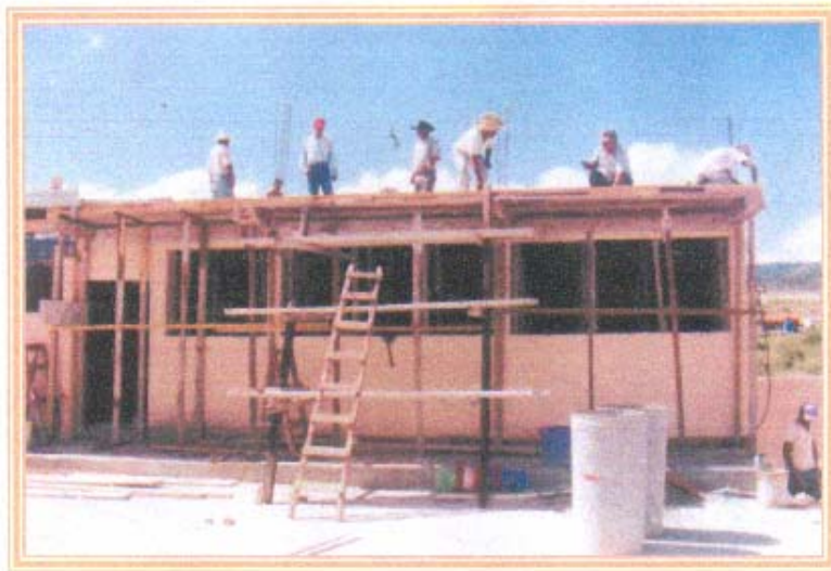
Colocación de manguera para la instalación eléctrica
