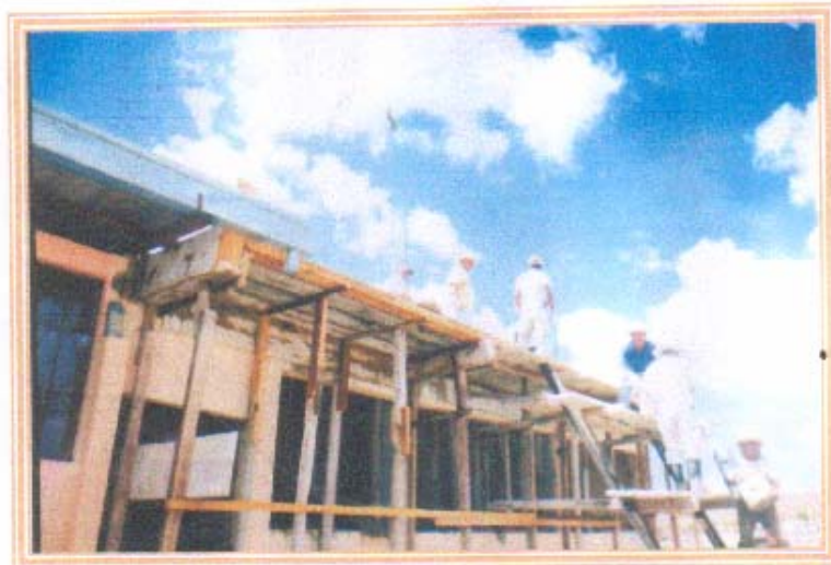
Proceso de fundición de la sala de informática (6 horas).
