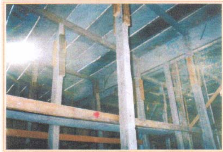
Colocación de madera (tablas y parales) preparando para la colocación del hierro.
