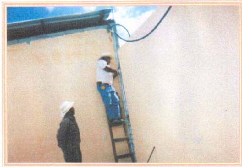
Reforzando columnas (7 columnas) para el sostenimiento de la loza en la sala de informática.
