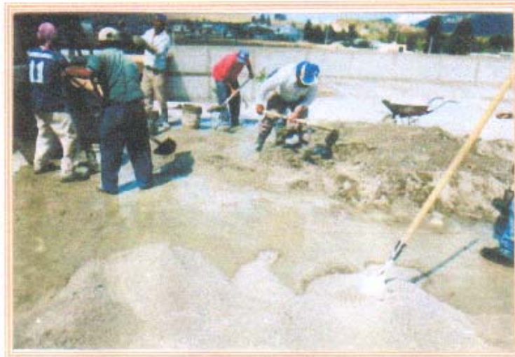
Preparación de material para fundir la loza en la sala de informática.
