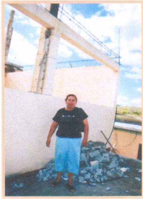
Destechado (lámina y costaneras) del aula que servirá para sala de informática de la Facultad de Humanidades Sección Jalapa.
