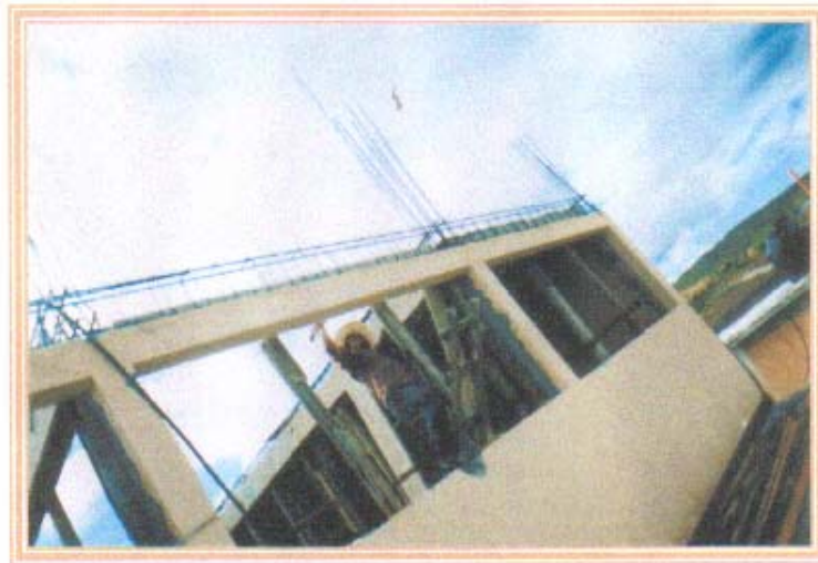
Elaboración con hierro de las vigas aéreas y corona del aula de informática
