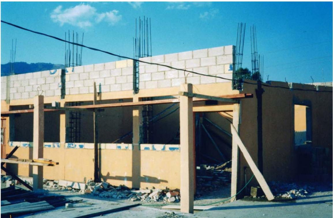
En esta fotografía aparece levantamiento de pared para colocar la losa.
