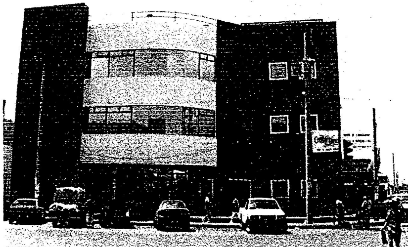
EL 18 DE ENERO DE 2003. FUE INAUGURADO EL MODERNO EDIFICIO DE COOPERATIVA U.P.A., FRENTE AL PARQUE CENTRAL DE AMATITLÁN.
