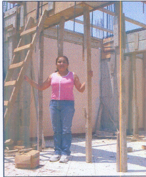
Foto 5 Colocación de madera en vigas y costaneras
