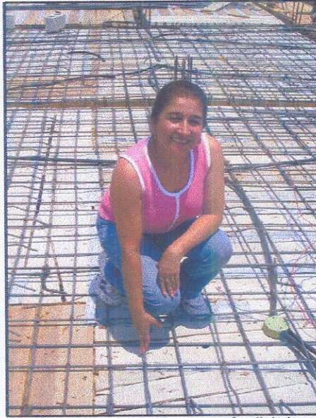
Foto 8 Armazón de hierro para fundir la losa
