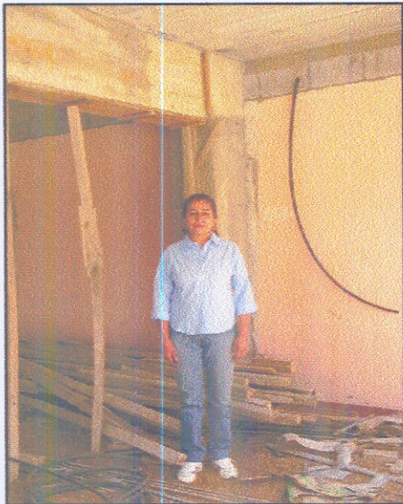
Foto 9 Colocación de Poliducto
