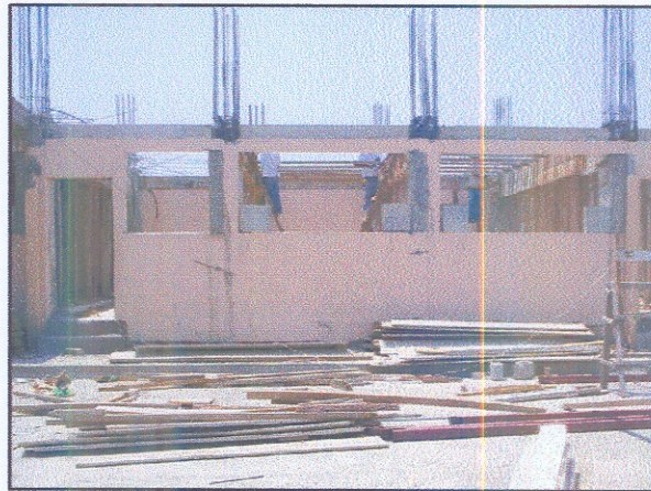
Foto 3 Columnas de refuerzo
