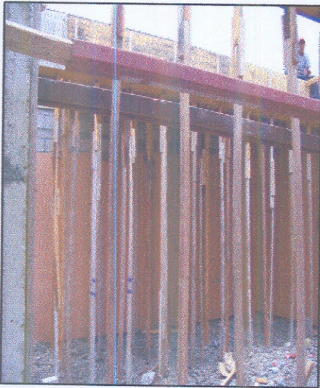
Foto 6 Colocación de parales
