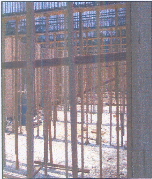
Foto 4 Armazón de hierro de vigas y costanera
