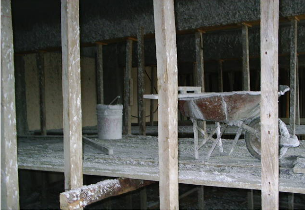
Foto 13. Entarimado para acabado de techo
