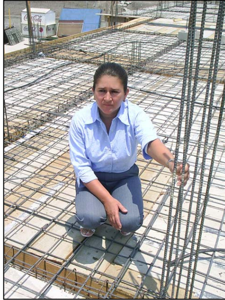
Foto 10. Armazón de hierro del techo.
