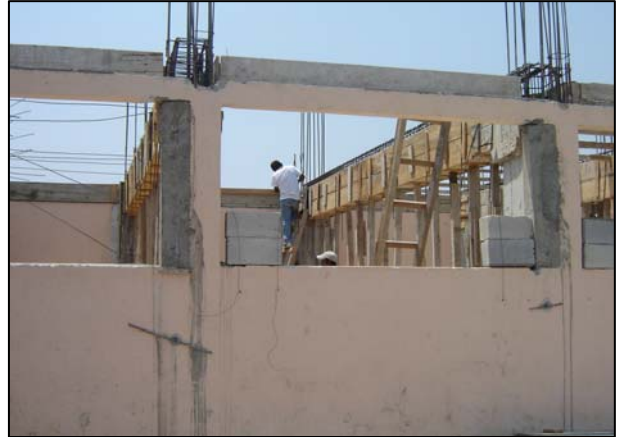
Foto 5. "Encajelado" de Viga para fundición.
