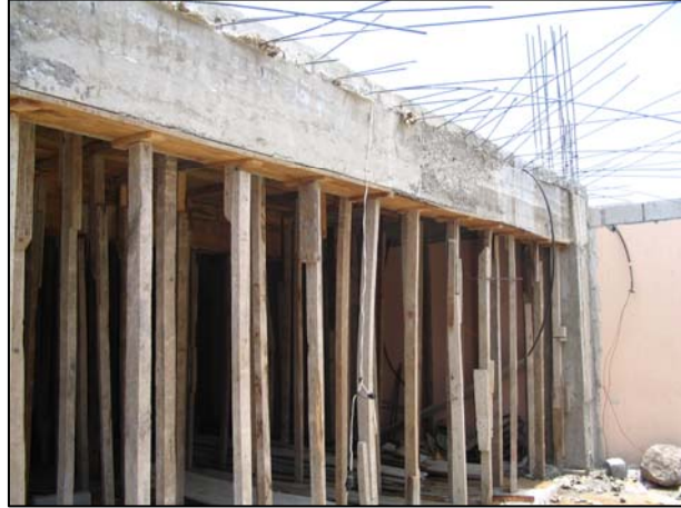
Foto 7. Viga ya fundida.
