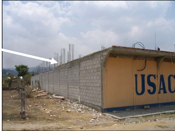
Foto 1. Vista exterior del aula seleccionada para reconstrucción.
