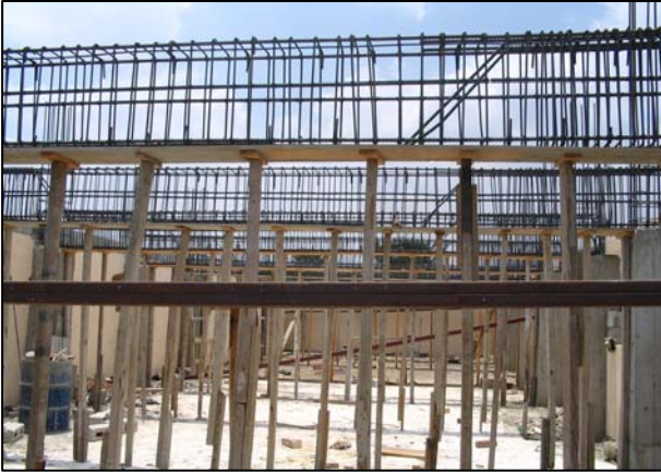
Foto 4. Armazón de hierro de vigas y costaneras.
