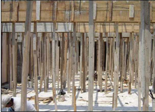
Foto 8. Colocación de parales.
