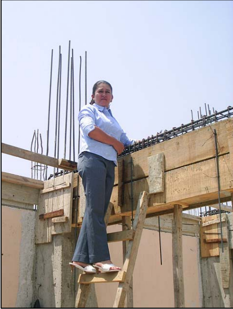
Foto 6. Previo a fundición de la Viga
