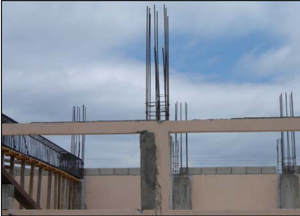
Foto 2. Columnas de Refuerzo
