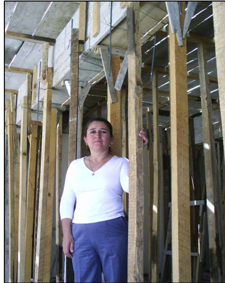
Foto 9. Colocación de tablas
