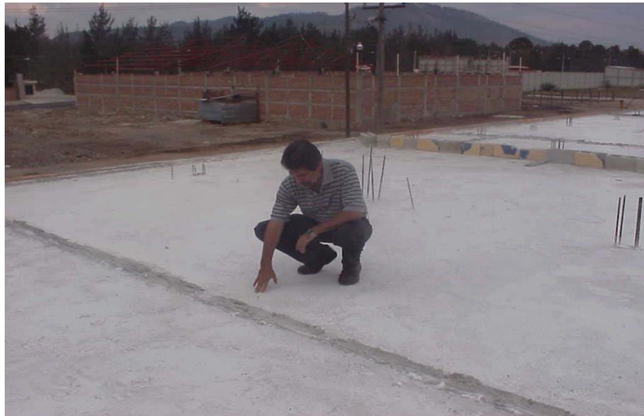
En esta fase se ha fundido la losa o terraza, la cual lleva un proceso especial de secado para evitar filtraciones de agua.
