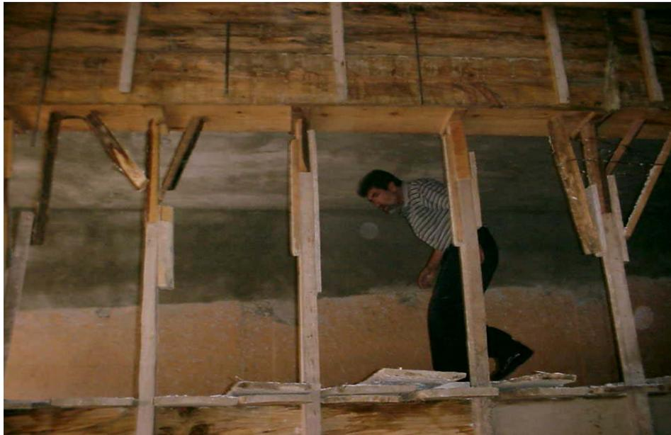
En esta fase se observa el proceso de secado de la losa o terraza, el cual debe ser gradual para evitar las agrietaduras.
