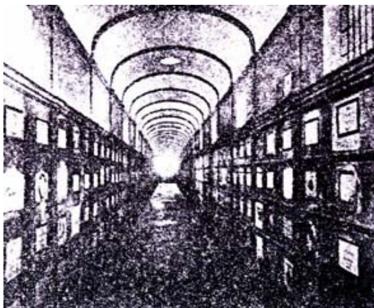
Galería subterránea de nichos del Cementerio General.
